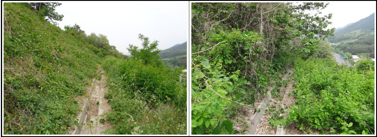
【그림 1.3.7】배수시설 전경
