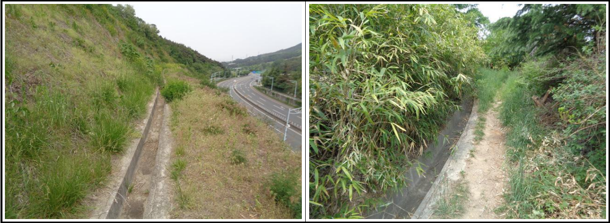
【그림 1.3.3】배수시설 전경
