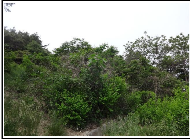
【그림 1.3.1】상부자연사면 전경
