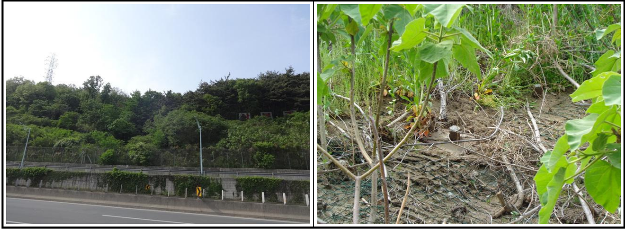
【그림 1.3.8】보호/보강시설 전경
